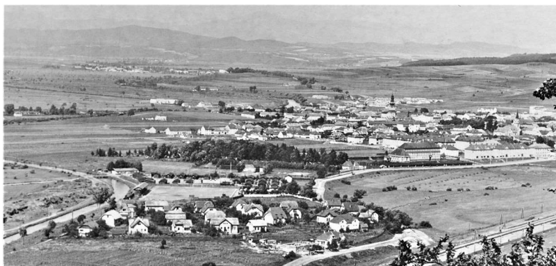
Obr. 1: Krajina Zvolena pri pohľade z pustohradskej rozhľadne v 30-tych rokoch 20. storočia. V prvom pláne Krivá púť, vpravo na lúke lemovanej krivkou cesty vidieť stopy po meandroch Slatiny, ďalej mesto rozrastajúce sa „za múry“. Centrálnu polohu zaujíma Borová hora s architektonickou dominantou Ozdravovne mesta Zvolen autora G. Stadtruckera. Dokument z archívu G. Lehockého.
